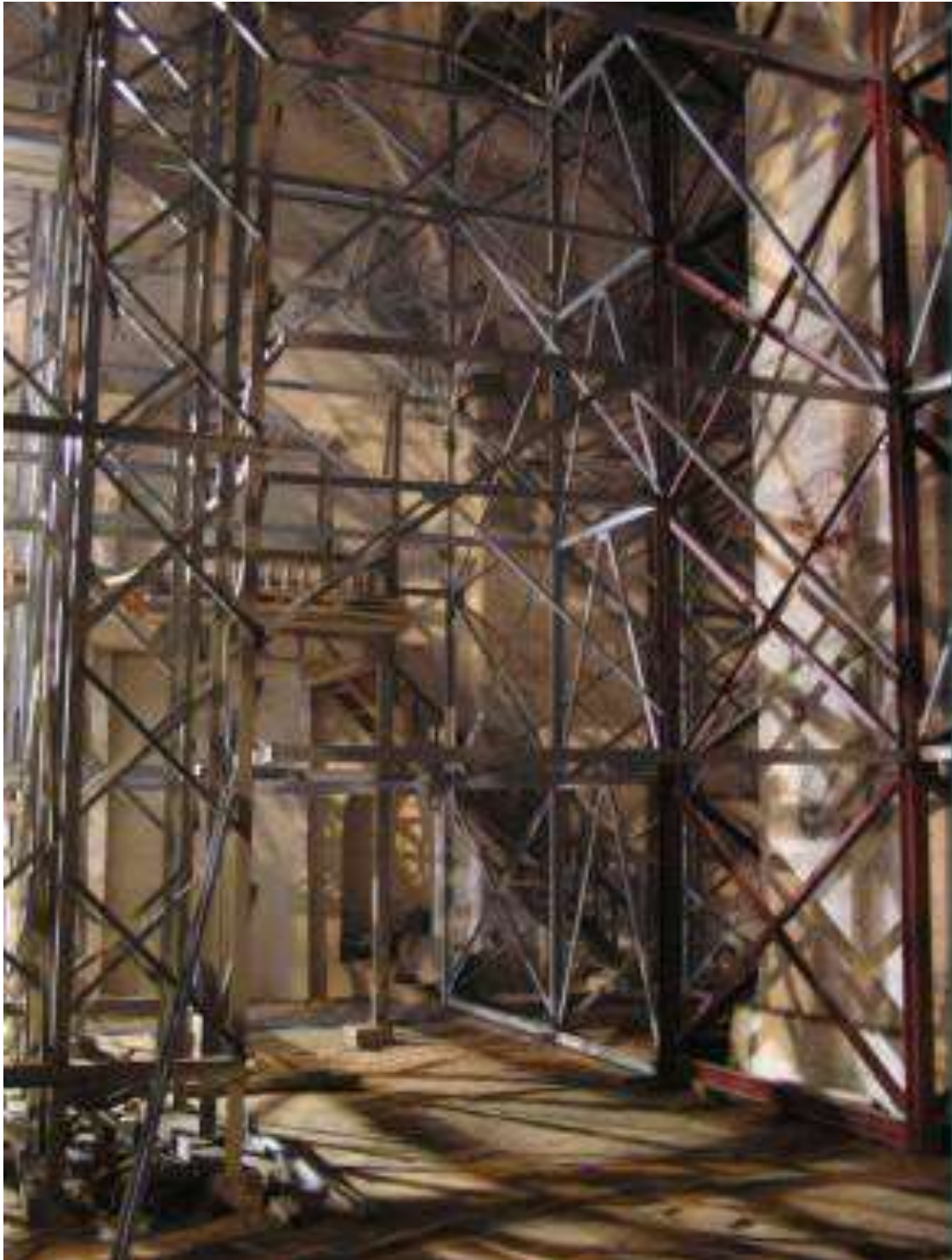
Εικ.23: Η κατασκευασθείσα (1985), εσωτερική μεταλλική σκαλωσιά για πρόσβαση στη στέγη, υποστήριξη των εργασιών συντήρησης εσωτερικά σε πρώτη φάση και εξωτερικά αργότερα. Πρόσφατα, μια τεραστίων διαστάσεων πρόσθετη μεταλλική κατασκευή τοποθετήθηκε εξωτερικά του μνημείου, με σκοπό τη στήριξη ενός στεγαστρου για την προστασία του μνημείου(!).
