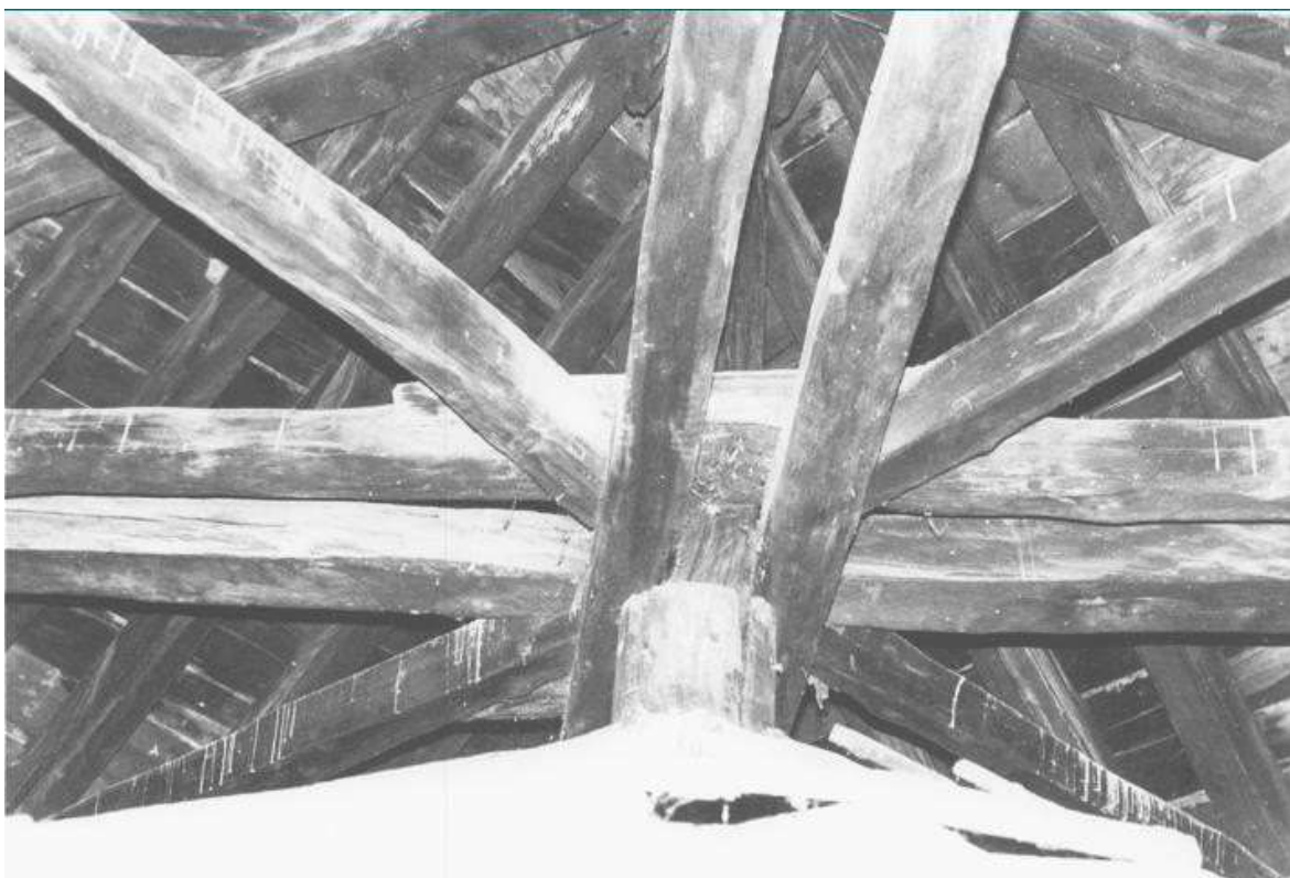
Εικ. 21: Διάφραγμα πλέγματος δοκών στην κορυφή του θόλου.
