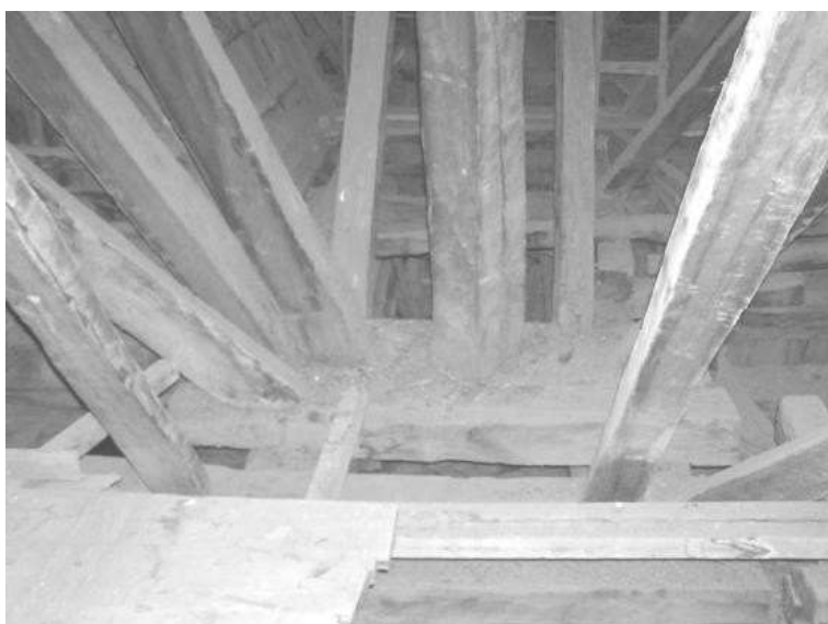
Εικ. 7: Έδρανο δοκών και αντηρίδων στην άνω απόληξη του δυτικού πεσσού.
