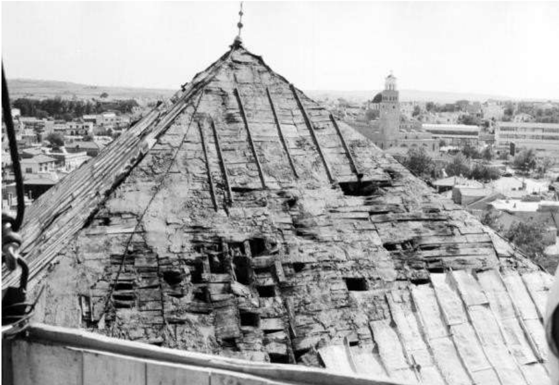
Εικ. 22: Άποψη της στέγης κατά την αφαίρεση των μολυβδοφύλλων.
