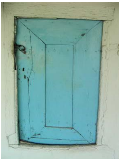
Εικ. 7: Καρφωτή εσωτερική θύρα με φαρδιές σανίδες. Εμμ. Παπάς (Α.Μ.447)
