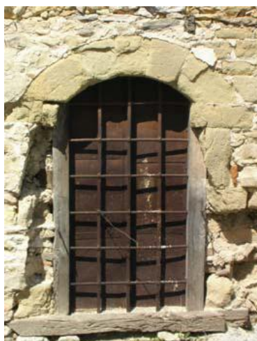
Εικ. 8: Παράθυρο κατωγίου με ισχυρή σιδεριά και μεταλλικά κανάτια. Αλιστράτη (Α.Μ.325)
