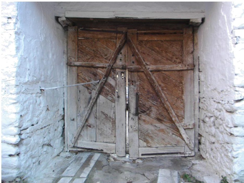
Εικ. 2: Δίφυλλη αυλόθυνα που ασφαλίζει με το διαγώνιο σίδερο. Εμμ. Παπάς (Α.Μ.433)
