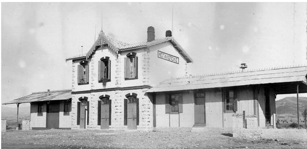
Εικ. 5: Ο Σιδηροδρομικός Σταθμός Β΄ Τάξης στη Μεγαλόπολη Αρκαδίας, κατασκευής Σ.Π.Α.Π. το 1898. Εκατέρωθεν του σταθμού, δύο βελγικά, λυόμενα, μεταλλικά κτίρια: αριστερά αποθήκη και δεξιά κατοικία.
