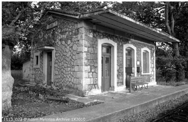
Εικ. 6: Ο Σιδηροδρομικός Σταθμός Γ΄ Τύπου στο Πλατύ Μεσσηνίας. Καταστράφηκε κατά τον Β΄ Παγκόσμιο Πόλεμο και ανακατασκευάστηκε το 1950 με χρήση του ίδιου οικοδομικού υλικού.
