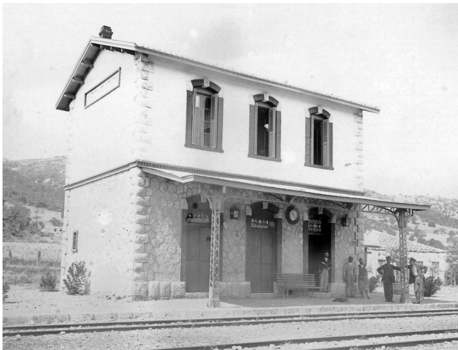
Εικ. 3: Σιδηροδρομικός Σταθμός Β΄ Τάξης στο Λεοντάρι Αρκαδίας
