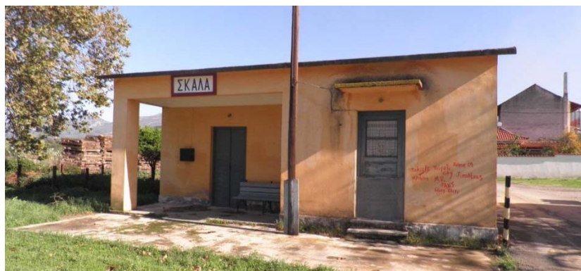
Εικ. 7: Η Σιδηροδρομική Στάση Γ΄ Τύπου στη Σκάλα Μεσσηνίας
