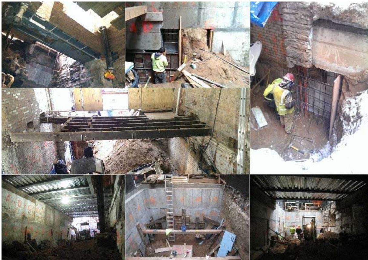
Εικ. 5: απόψεις κατά την εκσκαφή, την τμηματική υποθελίωση, τη στήριξη και τη απομάκρυνση δοκών και πατώματος για την τοποθέτηση μεταλλικών φορέων.
