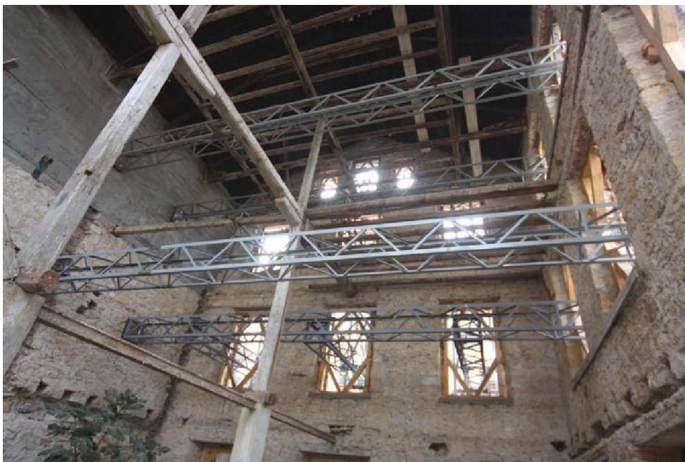
Εικ. 8: Άποψη του εσωτερικού του κτιρίου μετά την εφαρμογή της αντιστήριξης.
