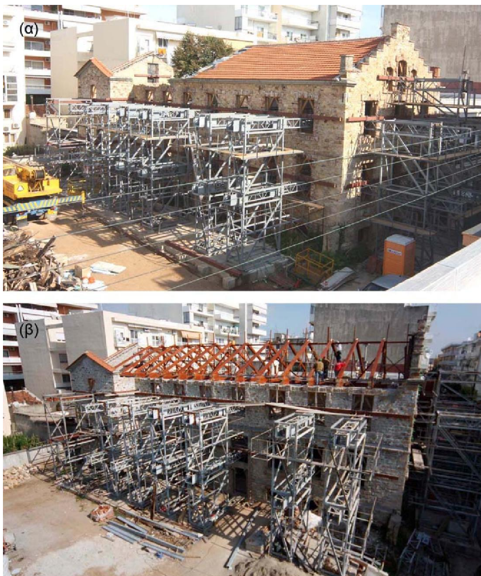
Εικ. 7: Γενική άποψη του κτιρίου α) μετά την εφαρμογή της αντιστήριξης και β) κατά την ανακατασκευή της στέγης
