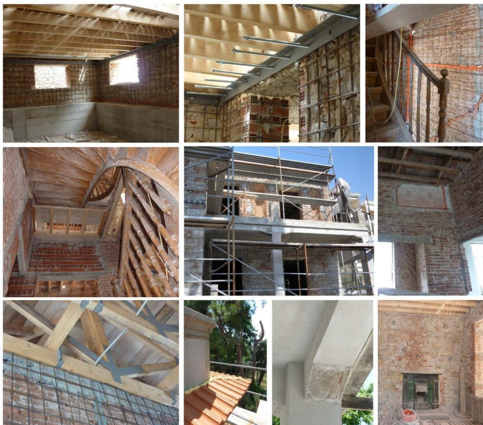
Εικ.8: Φωτογραφίες από τα στάδια των εργασιών ενίσχυσης και αποκατάστασης.
