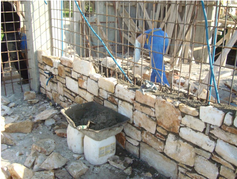
Εικ. 10: Κατασκευή φέρουσας τοιχοποιίας
