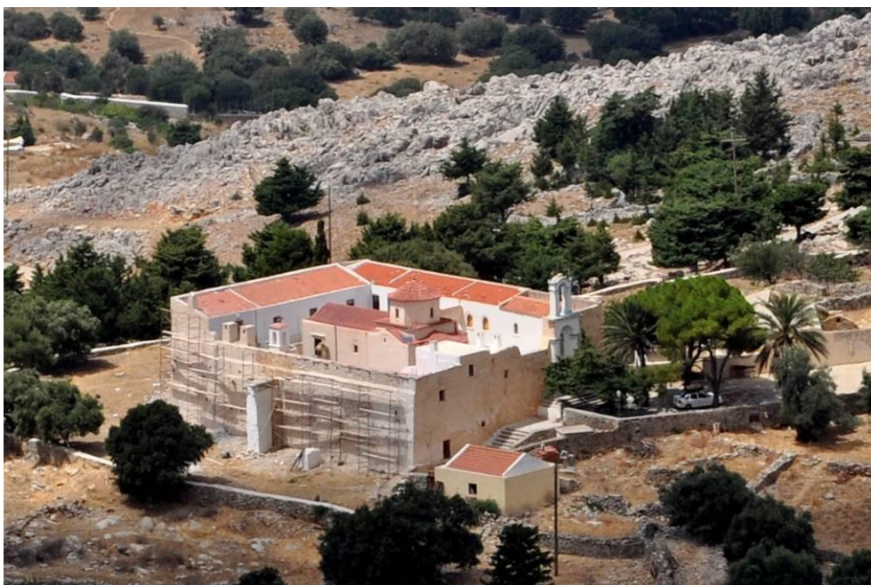
Εικ. 2: Νοτιοανατολική άποψη της Μονής Ρουκουνιώτη, από ψηλά, κατά τη διάρκεια των εργασιών αποκατάστασης. Ιούνιος 2014.
