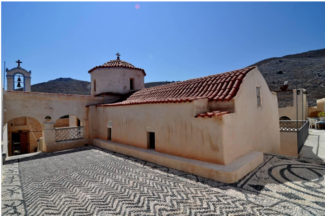
Εικ. 8: Βορειοδυτική άποψη του τρίτου επιπέδου. Διακρίνεται το άνω Καθολικό, εξωτερικά και ο εγκάρσιος τοίχος, ο οποίος μεταφέρει τα βρόχйна ύδατα, προς τη στέρνα.
