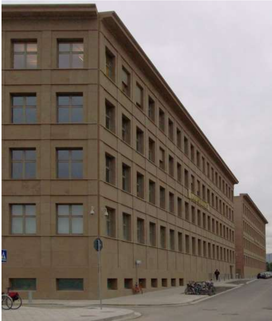
Εικ. 4: Το κτίριο της τράπεζας στη Νόβολη.
