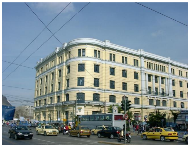
Εικ. 1: Γενική άποψη του σταθμού
