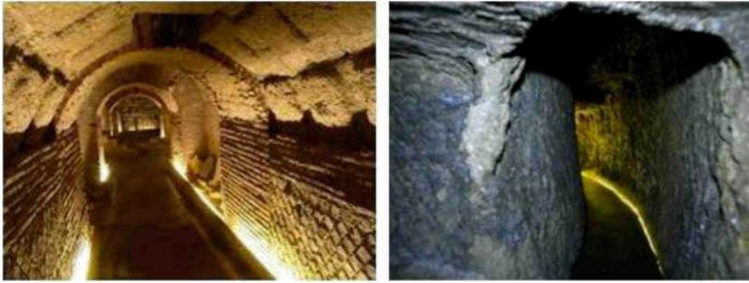
Εικ.1: αριστερά και δεξιά: κάτω Ιταλία-υπόγειο υδραγωγείο-χρήση διαφορετικής τεχνικής διάνοιξης αγωγού, διαφορετική γεωμορφολογία του υπεδάφους, (internet-acquedotti sotterranei)
