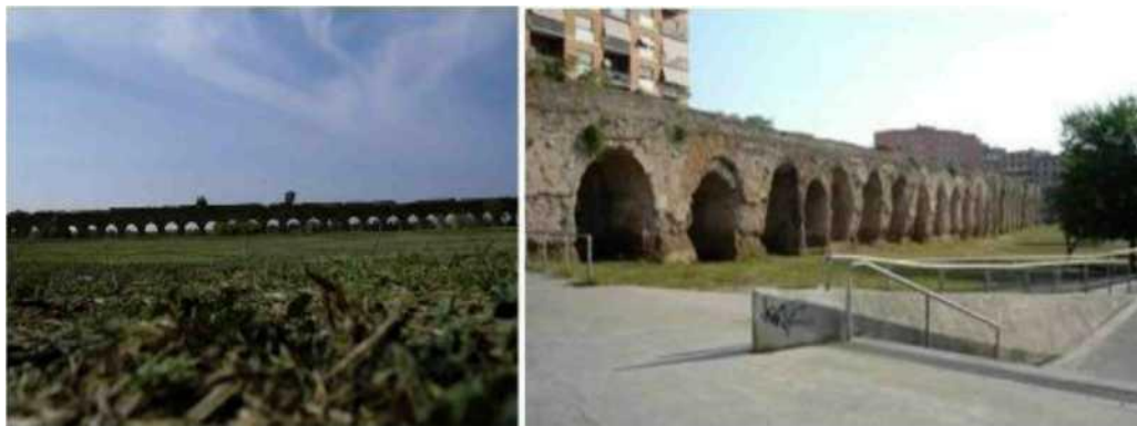
Εικ.2: Ρώμη, αριστερά: 1° υδραγωγείο-δεξιά: τελευταίο υδραγωγείο, (internet-foto acquedotti romani)
