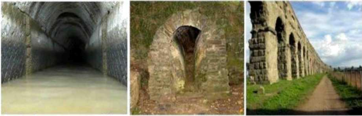
Εικ. 6: αριστερά: υπόγεια διαδρομή με αδιάβροχη επικάλυψη, κέντρο: τμηματική συνεχής διαδρομή σε μικρό υψος, δεξιά: συνεχής υπέργεια τοξοστοιχία. (internet-acquedotti romani)
