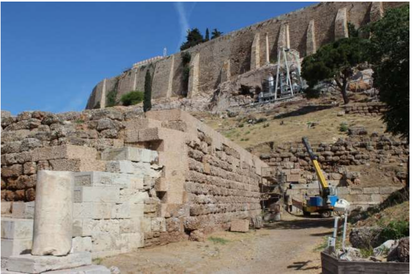
Εικ.8: Θέατρο του Διονύσου. Επεμβάσεις στο ανατολικό πλευρικό ανάλημα με τεχνητό κροκαλοπαγή λίθο. (Αρχείο Επιτροπής Νοτίου Κλιτίος Ακροπόλεως, 2013)
