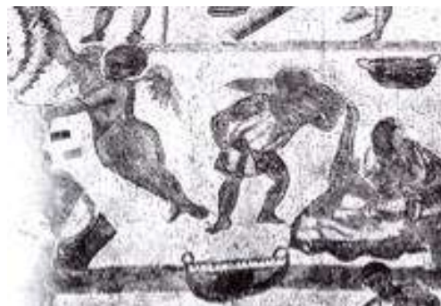
Εικ.4: Αναπαράσταση παρασκευής κονιάματος από δύο τεχνίτες σε ψηφιδωτό (Μουσείο Bardo, Τυνησία) (Adam, 1994, σ.76).
