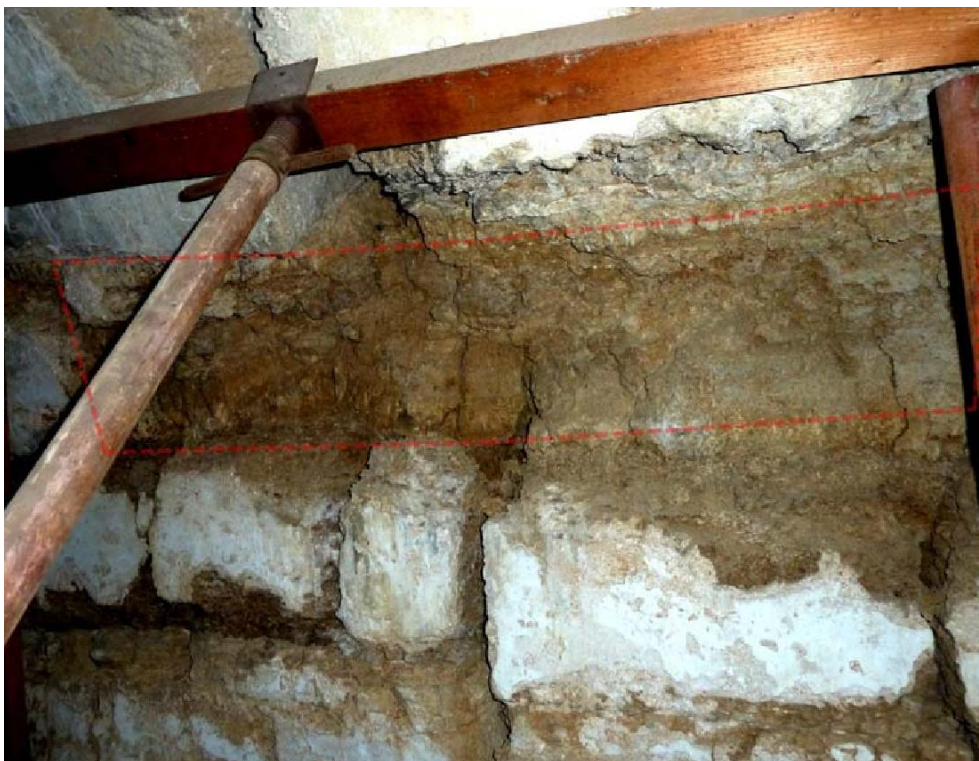
Εικ. 5: Εσωτερική όψη του θολίτη Θ17.2, πριν την επέμβαση. Είναι εμφανής ο έντονος κατακερματισμός του λίθου. Με κόκκινη διακεκομμένη, το θεωρητικό περίγραμμα της εσωτερικής του όψης
