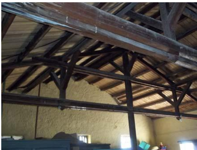
Εικ. 2: Το χαρακτηριστικό ζευκτό της στέγης του τμήματος Α του υπό μελέτη κτιρίου. Διακρίνονται οι διπλοί ελκυστήρες σε τρία επίπεδα και οι μονοί αμείβοντες
