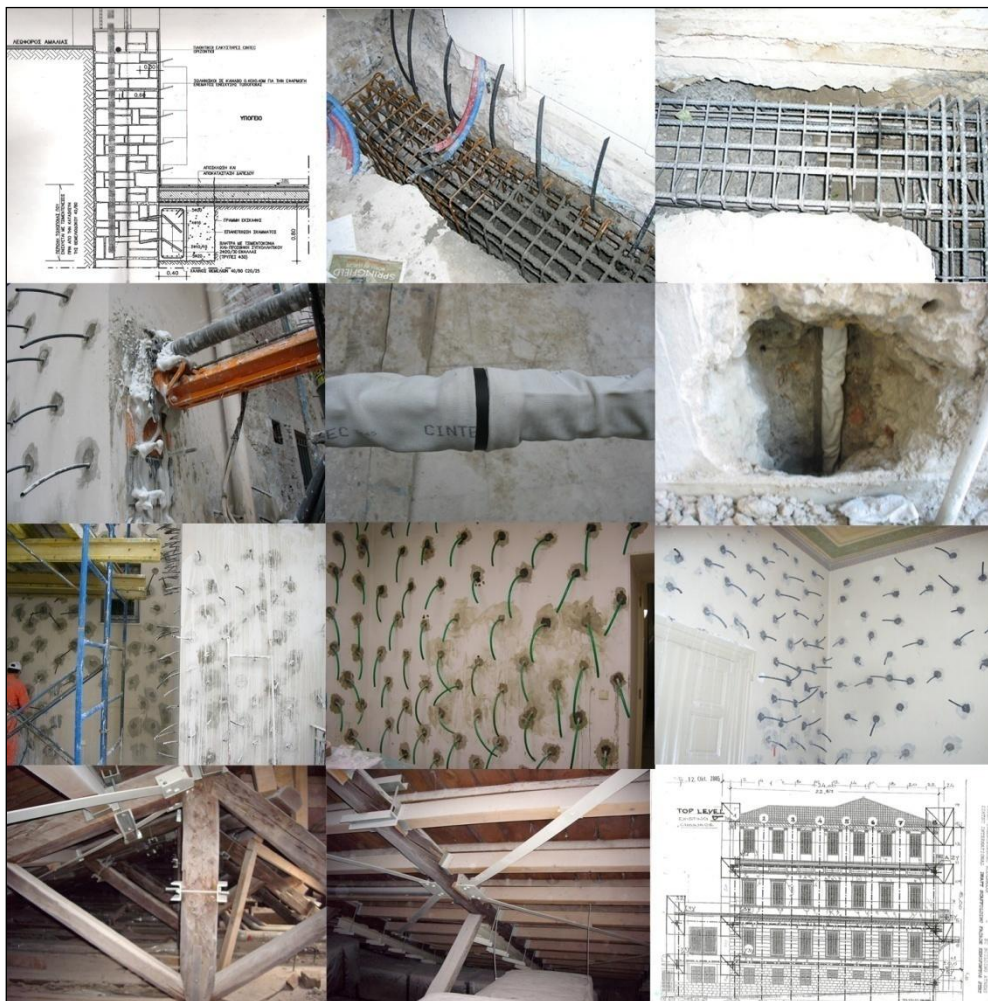
Εικ.6: Απόψεις από την ενίσχυση των θεμελίων, με κατασκευή περιμετρικής θεμελιοδοκού,, την ενίσχυση του κτιρίου με παθητικούς ελκυστήρες (η θέση των οποίων απεικονίζεται στο σχέδιο με τους διακεκομμένους κάθετους άξονες) και της τοιχοποιίας με τσιμεντενέσεις καθώς και η ενίσχυση της στέγης
