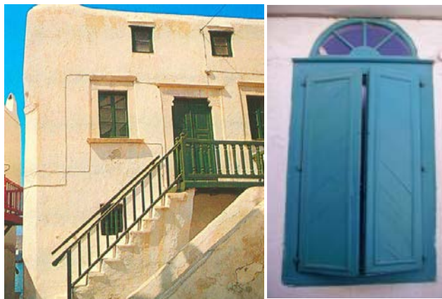
Εικ. 6α: Το παρελθόν: διαμπερής αερισμός με φεγγίτες στην όψη και μονόπλευρος αερισμός με φεγγίτες πάνω από το κύριο άνοιγμα
