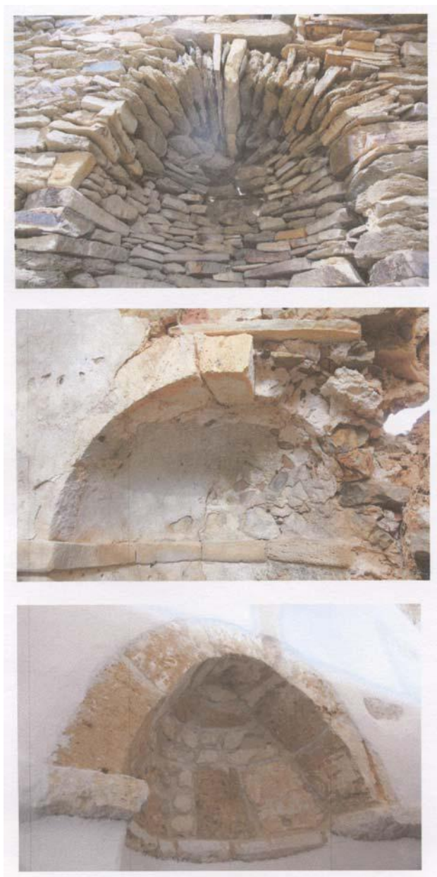
Εικ. 8: Κόγχες ιερού, υλικά και τρόπος δόμησης
