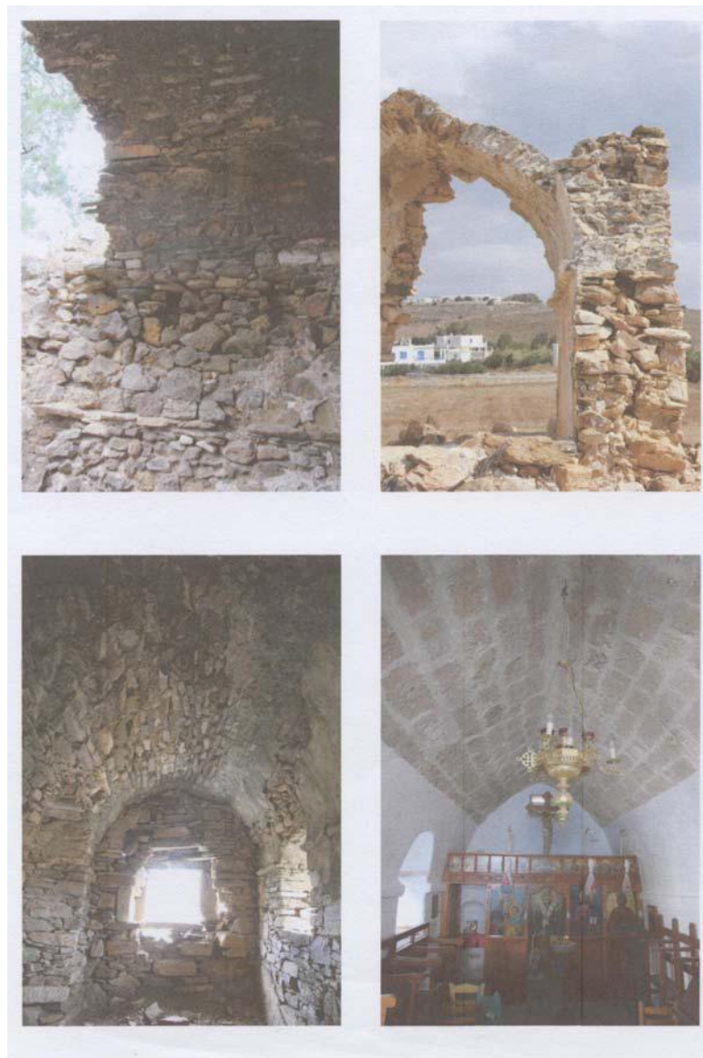
Εικ. 3: Υλικά και τρόπος δόμησης καμάρας
