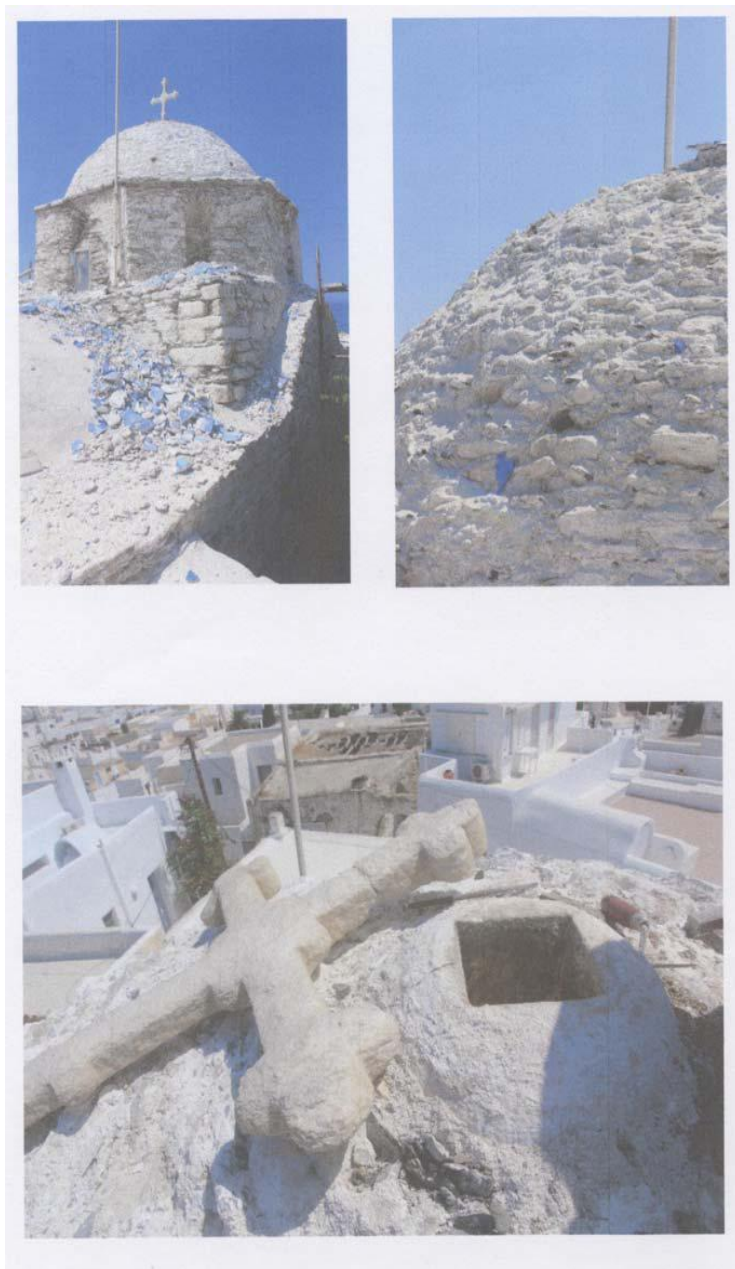
Εικ. 7: Υλικά και κατασκευή τρούλου Αγ Κωνσταντίνος, Παροικιά
