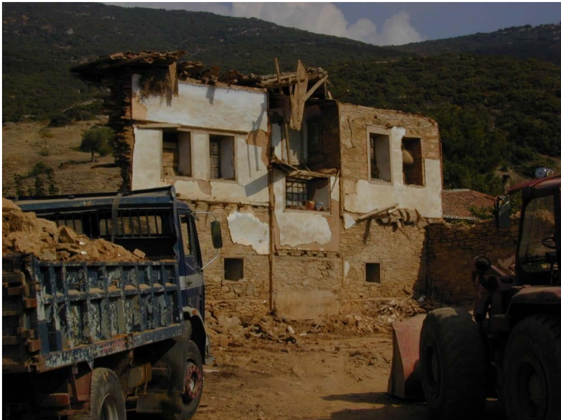
Εικ. 6: Κατεδάφιση του Αρχοντικού Φωτιάδη (6.10.1999)
