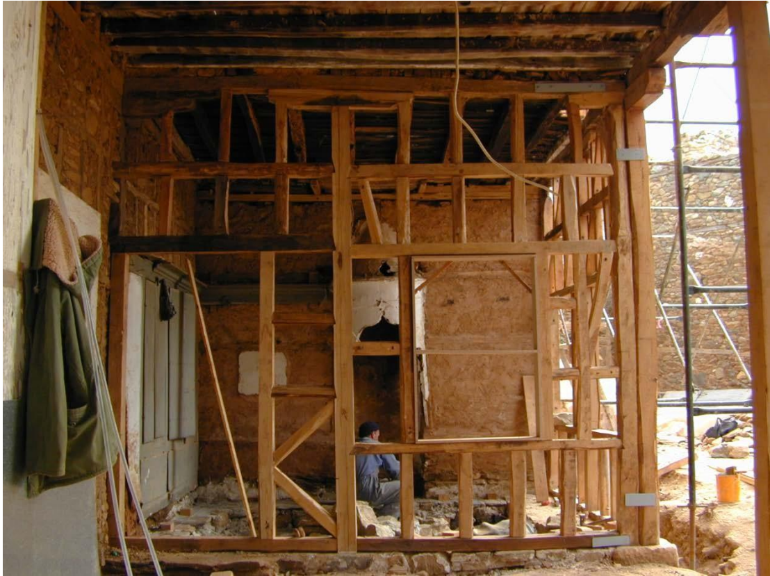
Εικ. 9: Αρχοντικό Ταβανιώτη, αποκατάσταση χώρου 1.03
