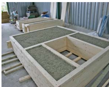
Εικ. 4: Το panel όπου τοποθετείται το άχυρο (Πηγή: www.modcell.com )
