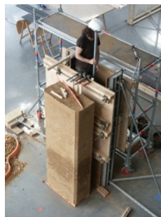
Εικ. 2: Η διαδικασία ανέγερσης μιας τοιχοποιίας από ρευστή γη
