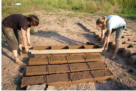
Εικ.1: Χειρονακτικός τρόπος κατασκευής ωμόπλινθων, Πηγή: www.flickr.com
