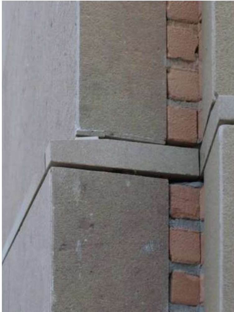
Εικ. 5: Λεπτομέρεια από το κτίριο της τράπεζας στη Νόβολη.
